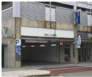
駐車場入り口付近
