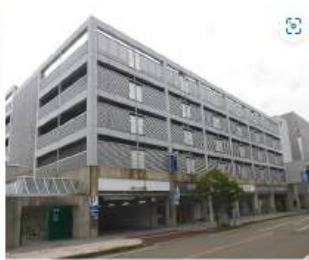
駐車場の全景
